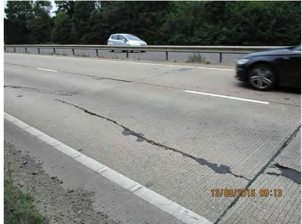
Longitudinal crack
